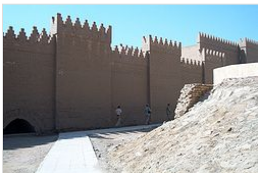
Les murs de Babylone après leur reconstruction récente.
